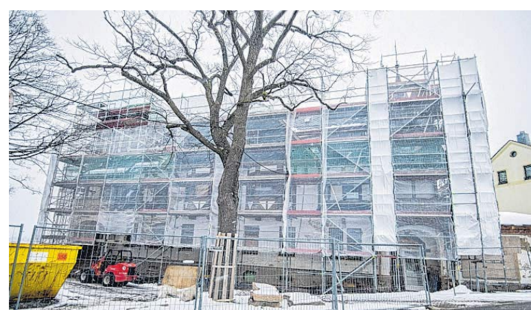
Das Fachwerkhaus am Schloss Hoheneck in Stollberg wird saniert. Ende des Jahres soll diese Maßnahme eigentlich abgeschlossen sein. Ob das klappt, steht aber in den Sternen.
